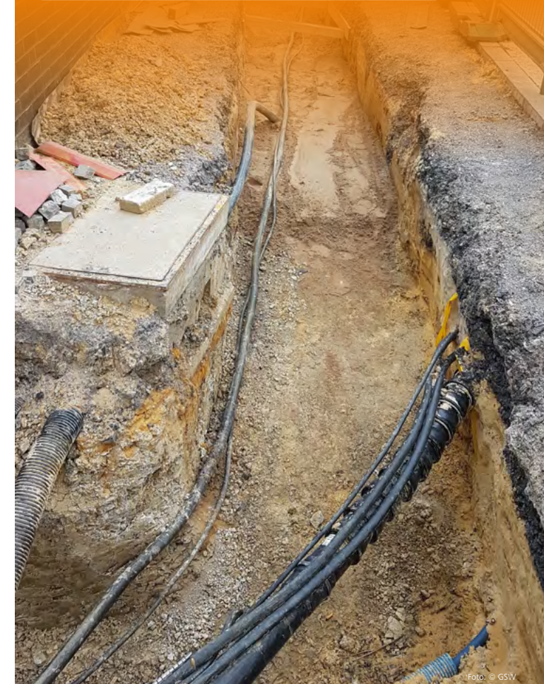
Anschlussarbeiten für das neue Stadtfenster Bergkamen an die Fernwärmeversorgung
